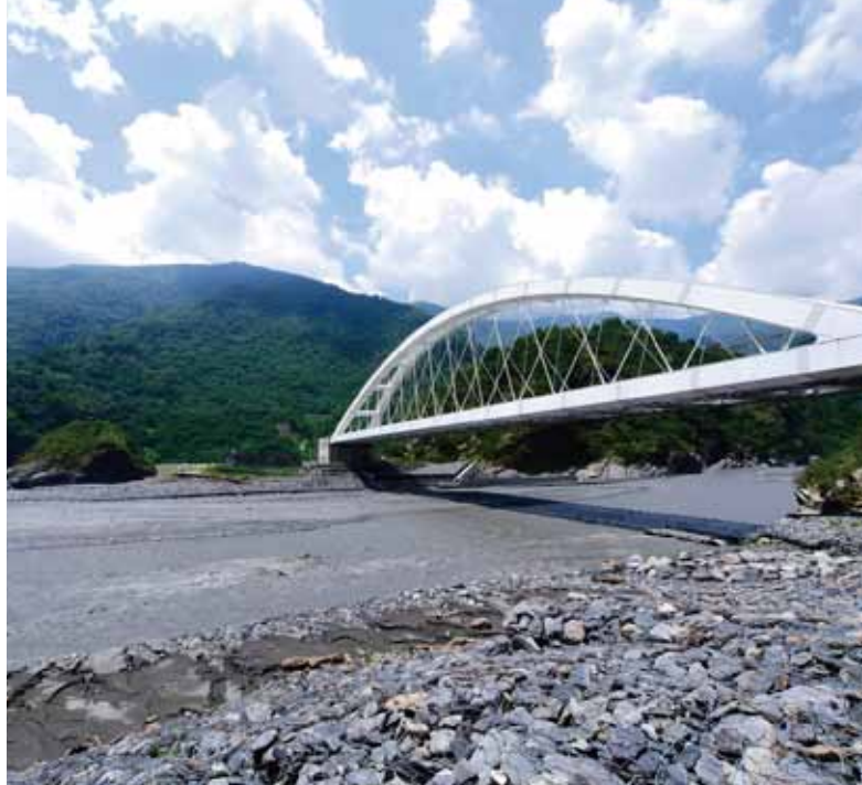
■ 新建的多納橋橫跨濁口溪
