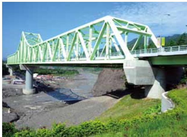
■ 新發大橋擁有美麗的鋼骨結構造型
