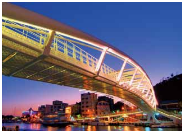
■ 鼓山區第一船渠人行橋
